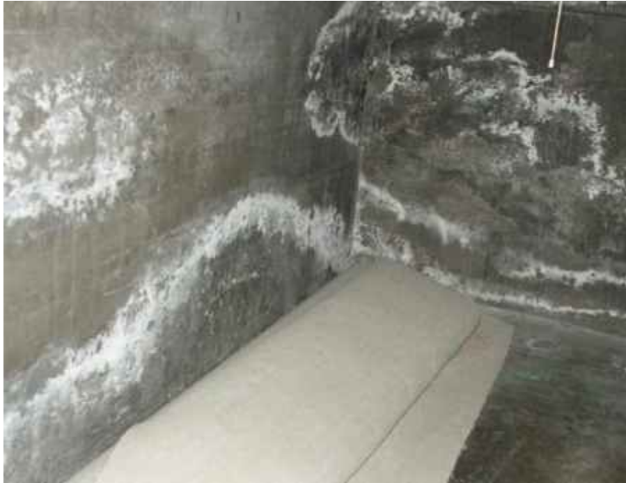
Fig : Efflorescence
