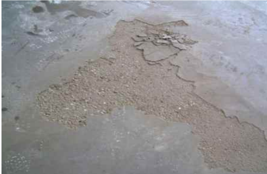
Fig : Delamination
