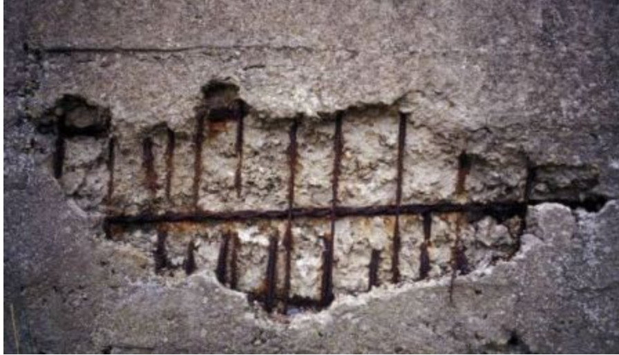
Fig : Spalling
